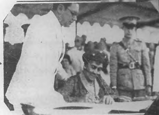
La señora ROSALBA ABREU, benefactora nuestra, que falleció recientemente en La Habana. Esta fotografía fue hecha en el momento en que firmaba el acta de colocación de la primera piedra de la Escuela Industrial para mujeres, construida a su costa.
